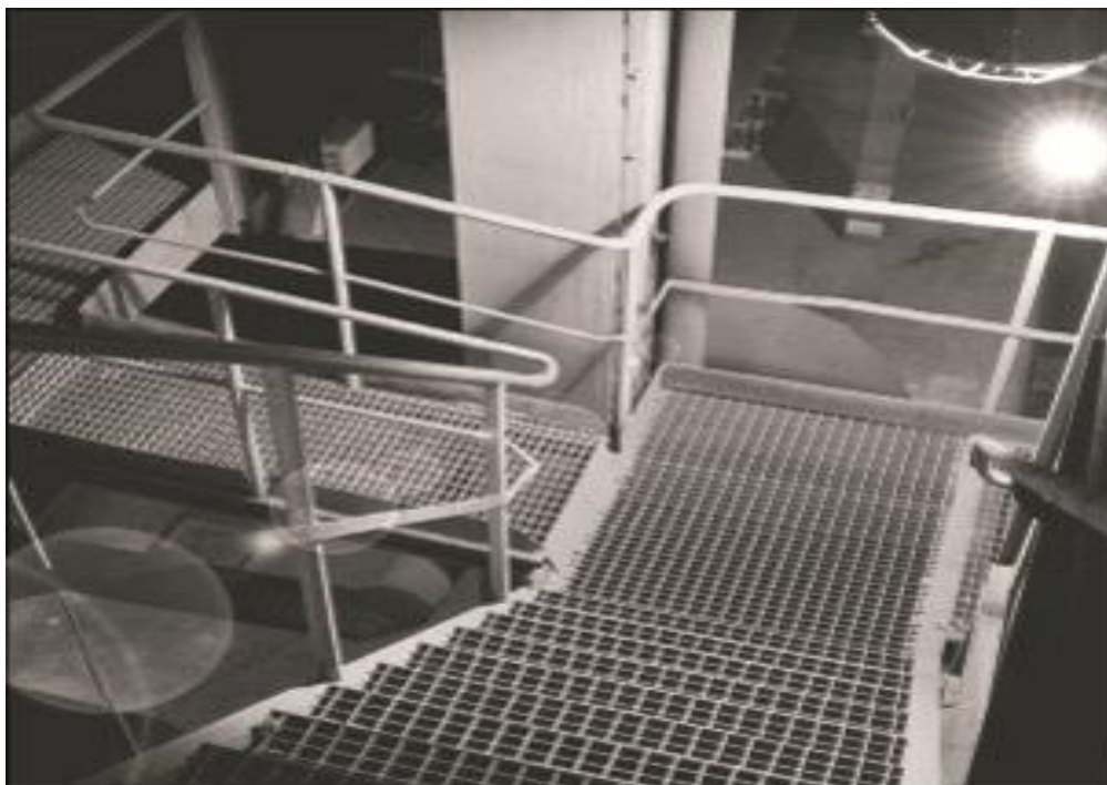
Presované rošty s osovou roztečí ok 33,3 x 33,3 mm a materiál S235 JR+N St 37-2 (ČSN 11375)
